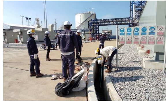
ภาพที่ 2-30 การทำความสะอาดรางระบายน้ำ
