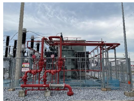
ภาพที่ 2-38 อุปกรณ์ป้องกันเพลิงไหม้ และระบบดับเพลิง
