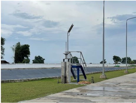
ภาพที่ 2-29 รางระบายน้ำฝนที่เชื่อมต่อกับกับบ่อกักน้ำดิบ ภายในโครงการ
