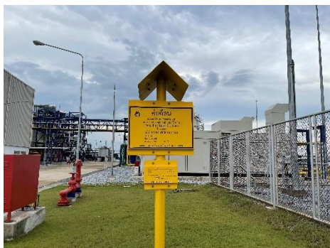
ภาพที่ 2-47 ป้ายแสดงเขตอันตรายบริเวณแนวท่อส่งก๊าซ
