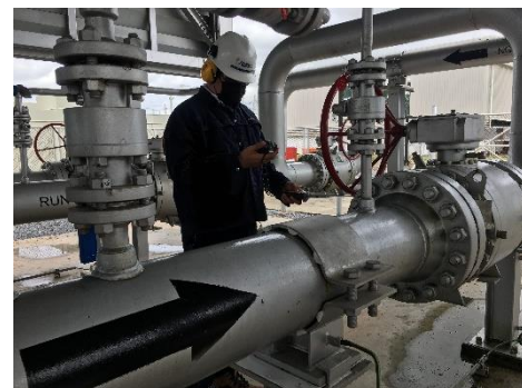
ภาพที่ 2-48 ตรวจสอบการรั่วไหลของท่อโดย Gas detector
