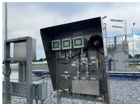
ภาพที่ 2-17 ระบบตรวจสอบคุณภาพน้ำทิ้งแบบต่อเนื่อง (Online Monitor) บริเวณจุดระบายน้ำทิ้งของโรงไฟฟ้า
