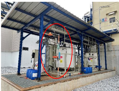
ภาพที่ 2-45 ฝักบัวอาบน้ำฉุกเฉิน และที่ล้างตาฉุกเฉิน
