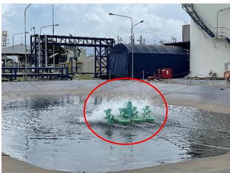
ภาพที่ 2-18 เครื่องเติมอากาศในบ่อพักน้ำทิ้งรวม
