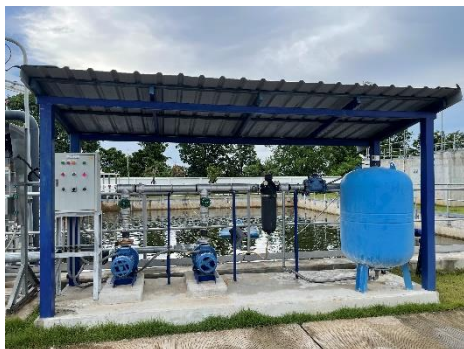
ภาพที่ 2-10 ระบบปั้มน้ำสำหรับรดน้ำต้นไม้
